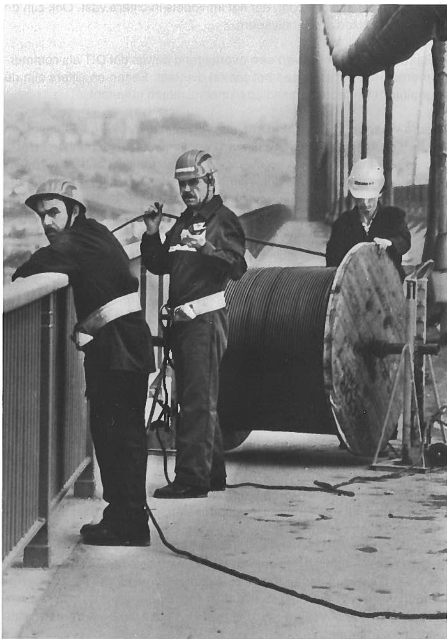
afb. 4 Internationale Telecommunicatie laat grenzen vervagen. Hier wordt Europa met Azië verbonden door een kabel over de Bosporus. foto Siemens
